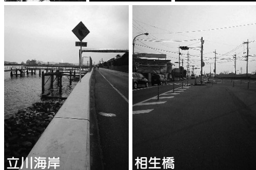
立川海岸 相生橋
